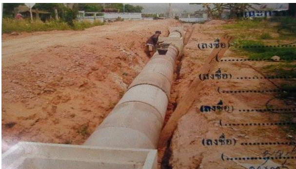
21. ก่อสร้างรางระบายน้ำแบบมีฝาปิด หมู่ที่ 2
